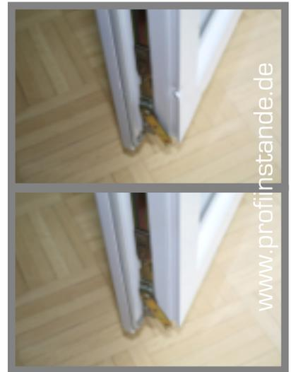
Beschädigungen an Tür- und Fensterelementen aus Kunststoff werden durch Wärmezufuhr mit einem PVC-Schweißgerät und mit speziellen Werkzeugen annähernd in ihre Ursprungsform gebracht.
