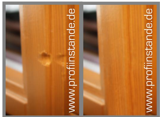
Bei schweren Beschädigungen an Türen und Fenstern aus Holz wird die schadhafte Stelle mit einem speziellen Fräsverfahren entfernt. Dies wird meistens durchgehend längs am betroffenen Profil ausgeführt.
