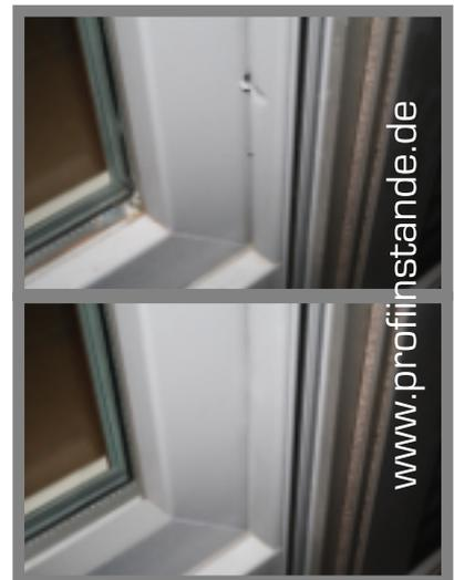
Bei Fenstern und Türen mit einer Dekor-Oberfläche (Farb- oder Holzdekor) werden die betroffenen Profile mit gleicher Folie erneut kaschiert.
