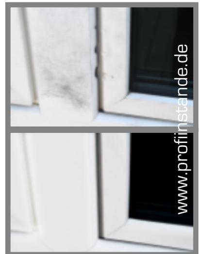
Seit kurzem verwenden wir ein neu entwickeltes Präparat, mit dem auch größere Schadstellen beseitigt werden können. Es ist ein Granulat, welches durch die Zugabe eines Fluid zu einer Substanz gebracht wird, deren Eigenschaften im ausgehärteten Zustand dem des Kunststoffes gleichen. Dieser RP-Harz ist ein hochwertiges thermoplastisches 2-Komponenten-Material, dessen Temperaturfestigkeit etwas höher liegt als bei PVC.
